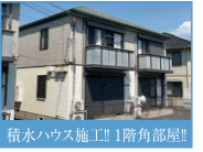
積水ハウス施工! 1階角部屋!!
