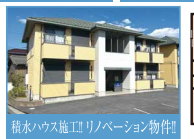
積水ハウス施工! リノベーション物件!
